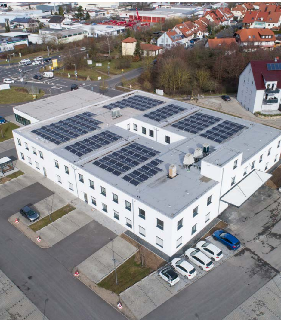
Das Foto (links) zeigt das fertige Gesundheitszentrum mit den Bauabschnitten 1 und 2. Das Gebäude wird mit regenerativer Energie versorgt, mittels Wärmepumpe und Photovoltaikanlage.
