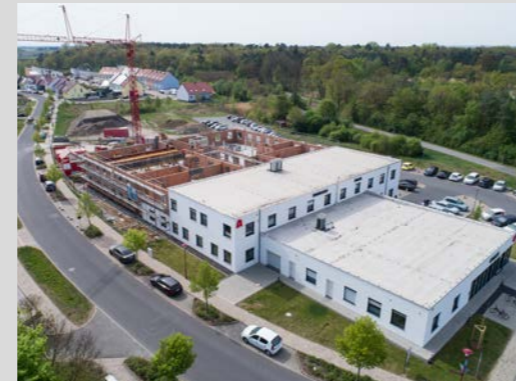
Das Baustellenfoto zeigt den 1. Bauabschnitt des Gesundheitszentrum Mainbogen im Vordergrund, welcher ebenfalls durch Riedel Bau realisiert und im November 2016 eröffnet wurde. Der Rohbau des zweiten Bauabschnittes ist links im Bild zu sehen.
