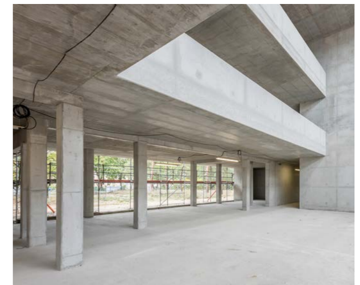
Das 11 m hohe Eingangsfoyer der Spree-Oberschule: Wände und Decken wurden in Stahlbeton in Sichtbetonqualität SB2 ausgeführt.
