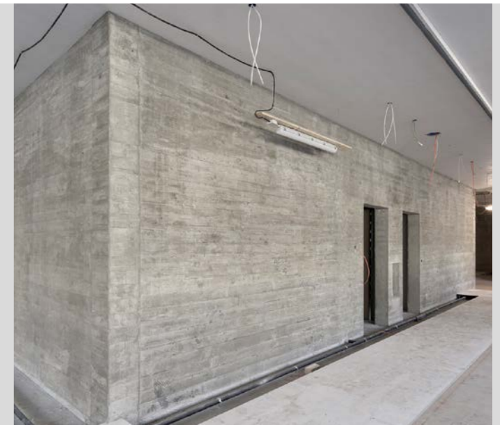
Das große Foto links zeigt das Foyer des Verwaltungsgebäudes mit einer ca. 50 m 2 großen Sichtbetonwand in die der Schriftzug „Deutscher Wetterdienst“ zusätzlich in die Brettschalung eingebracht wurde. Das nebenstehende Foto mit den Buchstaben „EU“ zeigt einen Ausschnitt aus dieser Foyerwand bei dem die sägeraue Brettstruktur des Sichtbetons gut erkennbar ist. Die so entstandenen natürlichen Oberflächen spiegeln die umwelt- und ressourcenschonende Bauweise dieses Objektes wider. Die Sichtbetonflächen wurden vorwiegend in den Fluren angeordnet. Neben dem Schriftzug „Deutscher Wetterdienst“, wurden auch die Begriffe „Speisesaal“ und „Rechenzentrum“ abgebildet.
