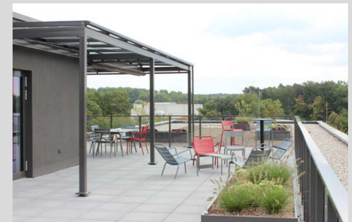
Die Dachterrasse des Anbaus wurde als Aufenthaltsfläche für die Mitarbeiter eingerichtet. Das Regenwasser wird auf dem Dach aufgenommen und gespeichert.
