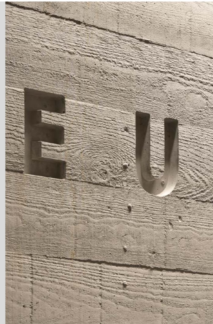
Das große Foto links zeigt das Foyer des Verwaltungsgebäudes mit einer ca. 50 m 2 großen Sichtbetonwand in die der Schriftzug „Deutscher Wetterdienst“ zusätzlich in die Brettschalung eingebracht wurde. Das nebenstehende Foto mit den Buchstaben „EU“ zeigt einen Ausschnitt aus dieser Foyerwand bei dem die sägeraue Brettstruktur des Sichtbetons gut erkennbar ist. Die so entstandenen natürlichen Oberflächen spiegeln die umwelt- und ressourcenschonende Bauweise dieses Objektes wider. Die Sichtbetonflächen wurden vorwiegend in den Fluren angeordnet. Neben dem Schriftzug „Deutscher Wetterdienst“, wurden auch die Begriffe „Speisesaal“ und „Rechenzentrum“ abgebildet.
