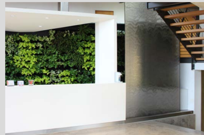
Erhöhte Luftfeuchtigkeit sorgt für gutes Raumklima und spart Heizkosten. Im Bestandsgebäude wurden eine Pflanz- und Wasserwand eingebaut, die das Raumklima positiv beeinflussen.
