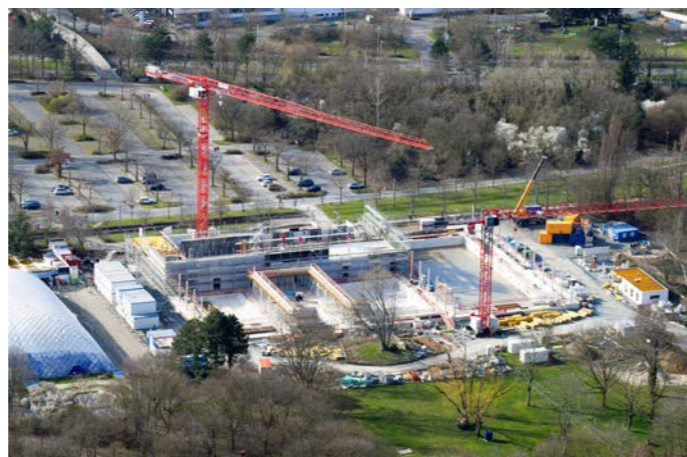
Die Baustelle des Nordbades in Darmstadt im März 2020.
