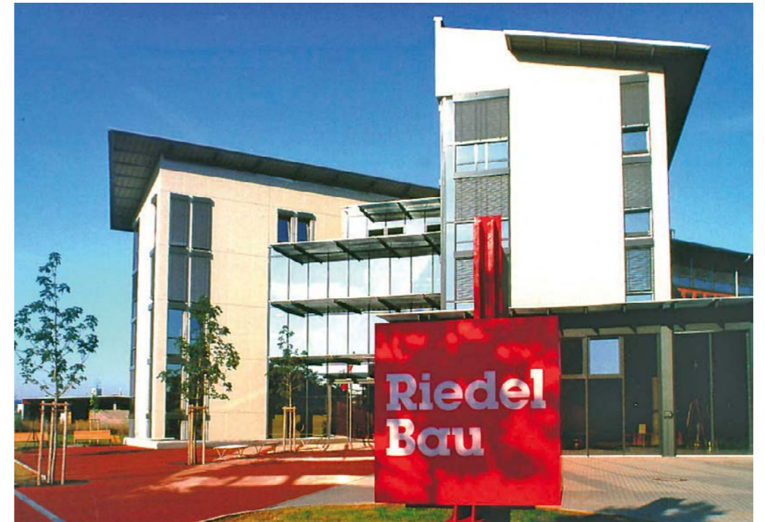
1997 - Neues Verwaltungsgebäude, Silbersteinstraße 4 im Schweinfurter Gewerbegebiet Hafen.
