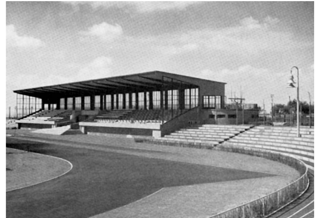
1935/36 - Erstellung der gesamten Anlage des Willy-Sachs-Stadions (Foto: Zuschauertribüne).
