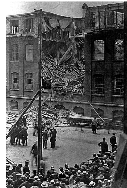
1911 - Einsturz der Schuhfabrik Heimann
