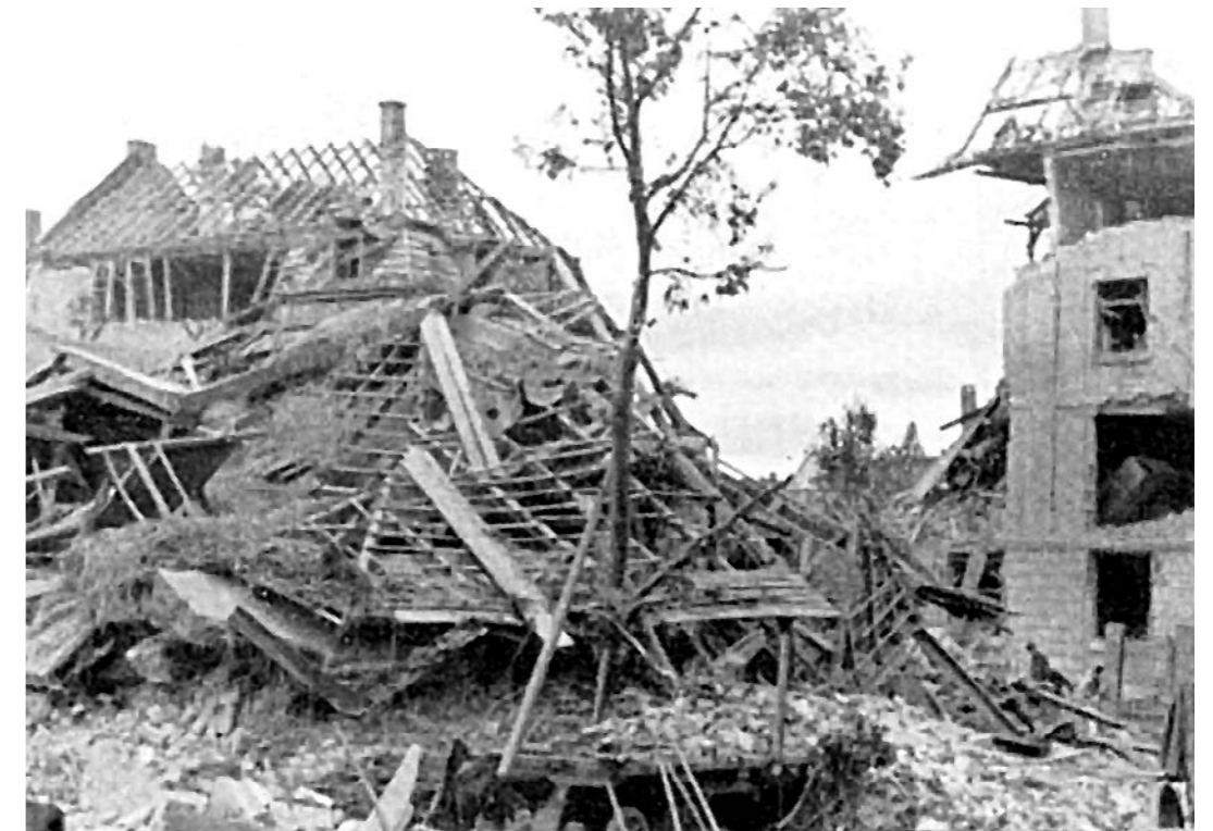
1944 - Der Firmensitz in der Cramerstraße nach einem Bombenangriff am 9. Oktober.
