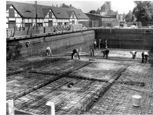
Bewehrungsarbeiten am Schwimmbecken des Ernst-Sachs-Bades in Schweinfurt.
