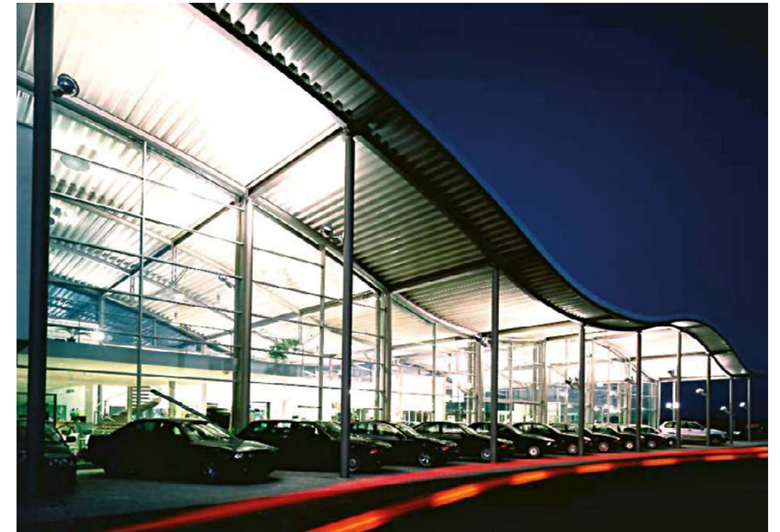
2000 - BMW-Autohaus Schweinfurt / Maintal (ARGE)
