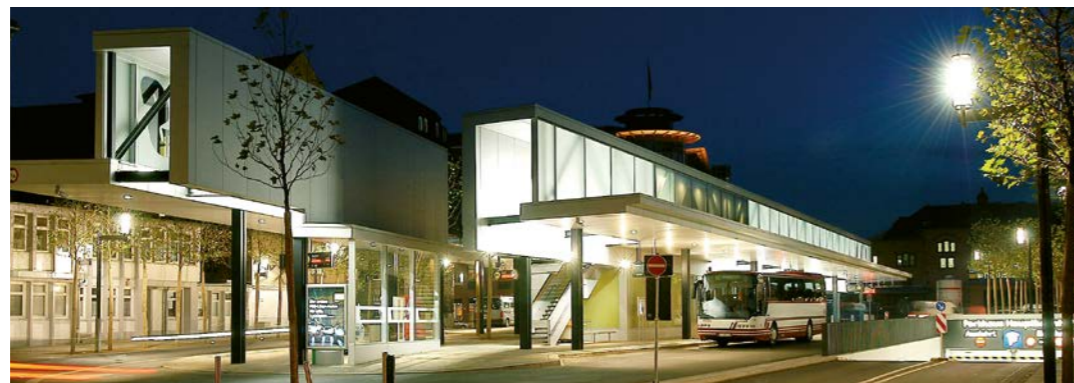
2002 - Zentraler Omnibusbahnhof, Erfurt
