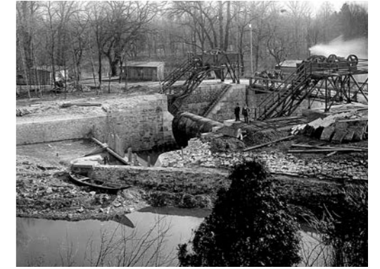
1903 - Bauarbeiten am Main-Hauptwehr (Maxbrücke) und an der Staustufe in Schweinfurt.
