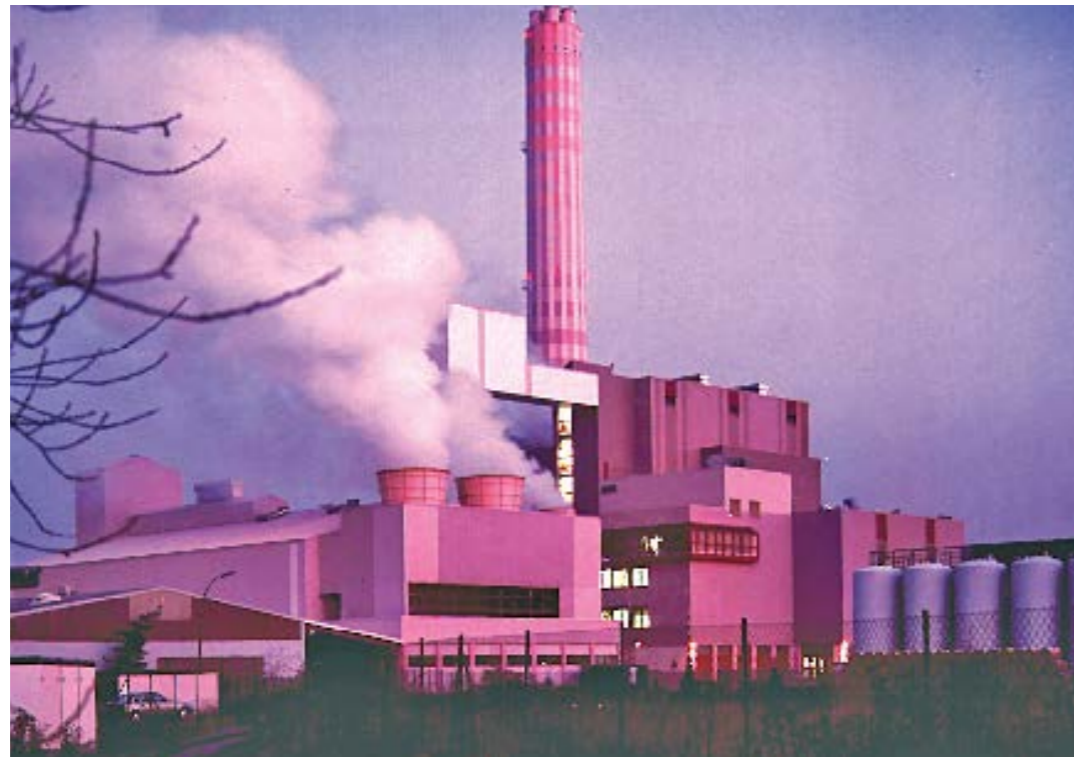
1988 - GKS Gemeinschaftskraftwerk Schweinfurt
