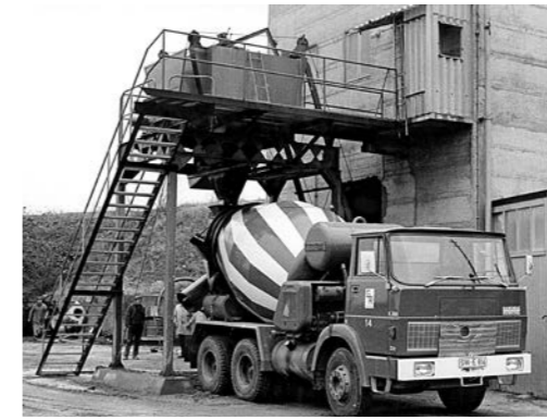
Das erste Transportbeton der Region wurde 1954 von Gebr. Riedel errichtet. Auch bei der Umstellung des Betontransports auf Fahrmischer war Riedel federführend. Das Foto von 1973 zeigt einen der ersten Betonfahrmischer mit einer 5 cbm fassenden Trommel.
