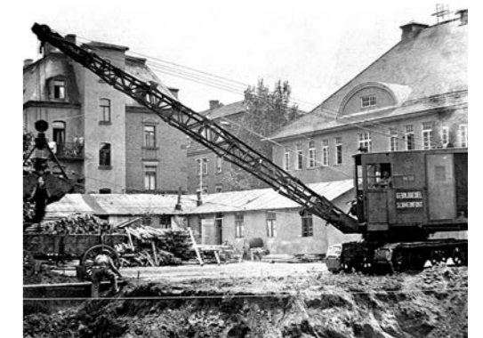
1927 - Menck-Bagger im Einsatz.
