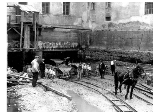
Elektrizitätswerk Schwandorf (Arbeiten mit Feldbahngleisen, Loren und Pferdezugwerken).
