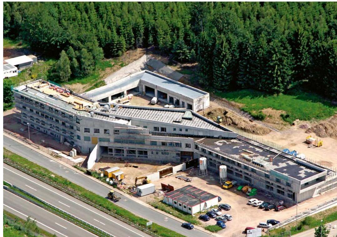
2004 - Neubau des Gefahrenabwehrzentrums an der BAB A71/A73 bei Suhl / Zella-Mehlis.
