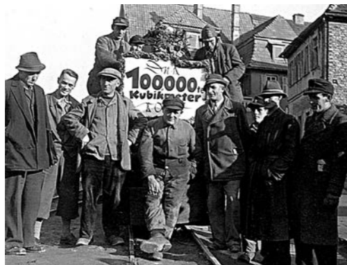
1945 - Beseitigung der Trümmer per Feldbahngleisen und Loren: Im Bild der 100.000 m 3 .
