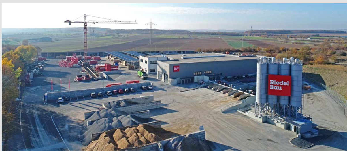
Riedel Bau Logistikzentrum mit Transportbetonwerk in Bergheinfeld, Schweinfurter Straße 137.
