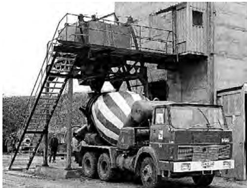
*Das erste Transportbeton der Region wurde 1954 von Gebr. Riedel errichtet. Auch bei der Umstellung des Betontransports auf Fahrmascher war Riedel federführend. Das Foto von 1973 zeigt einen der ersten Betonfahrmascher mit einer 5 cbm fassenden Trommel.*
