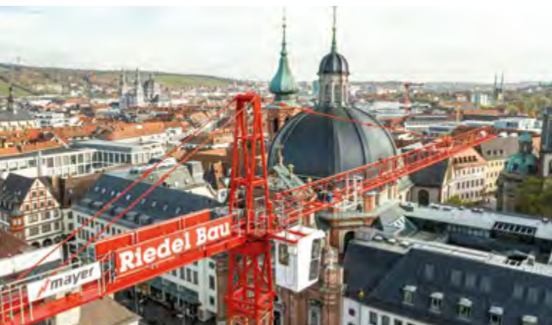
Baustelle Wohn- und Geschäftshaus Blasiusgasse, Würzburg
